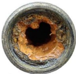
Querschnitt normales Trinkwasser Leitungsrohr nach ca. 10-15 Jahren
